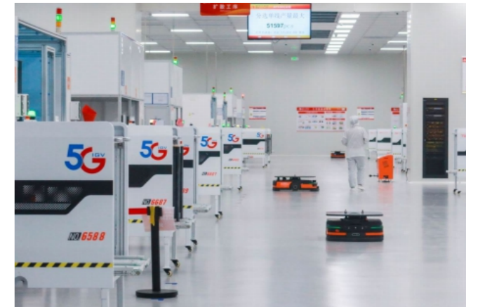
金堂通威光伏基地
